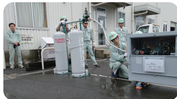
仮設ガス発生装置の設置訓練
